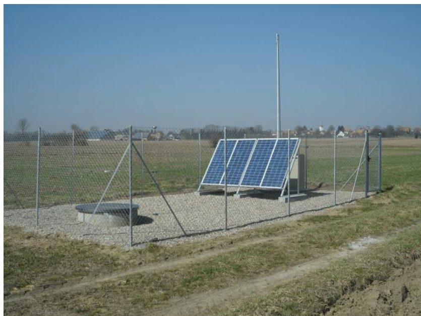
Figure 13 : Exemple d'une station sismologique de surveillance déployée dans le cadre du monitoring microsismique du projet de Rittershoffen. (Source : (Ravier et al. 2016))
