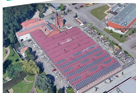
Panneaux photovoltaïques sur le toit du CTM
