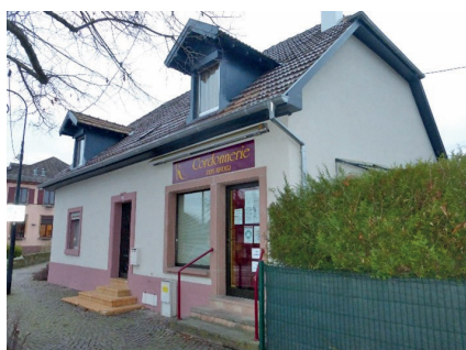
Rénovation de la façade de la cordonnerie
