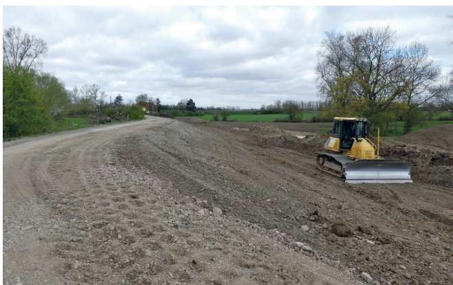
Travaux de sécurisation des Berges de l'Ill
