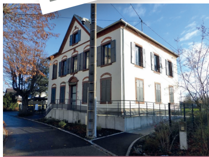
Travaux de réhabilitation du presbytère
